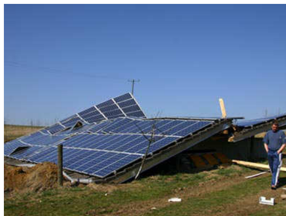
Imaginea 5: Module PV dărâmate de furtună
