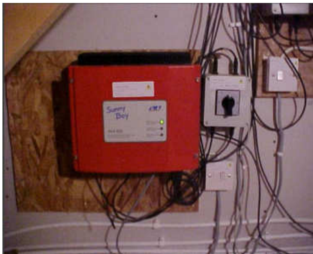
Imaginea 2: Cablare incorectă
