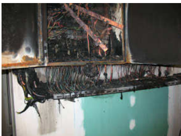
Imaginea 3: Scurt circuit și supra-tensiune
