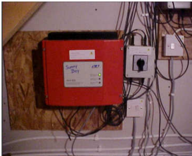
Slika 2. Nepravilno izvedene električne instalacije
