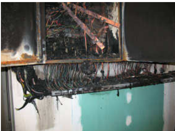
Slika 3. Kratki spoj i prenaponska zaštita
