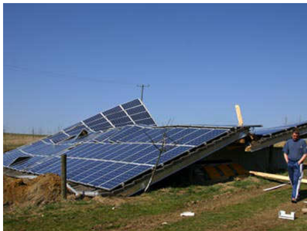
Imagen 5: Módulos dañados por una tormenta
