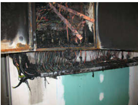
Imagen 3: Cortocircuito y de sobretensión en el convertidor
