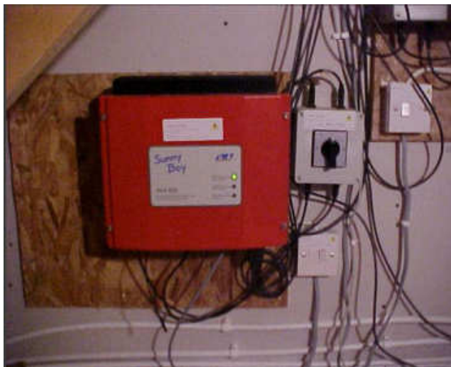
Imagen 2: Cableado inadecuado
