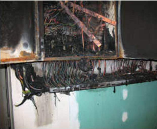
Εικόνα 3: Βραχυκύκλωμα και υπέρταση σε μετατροπέα
