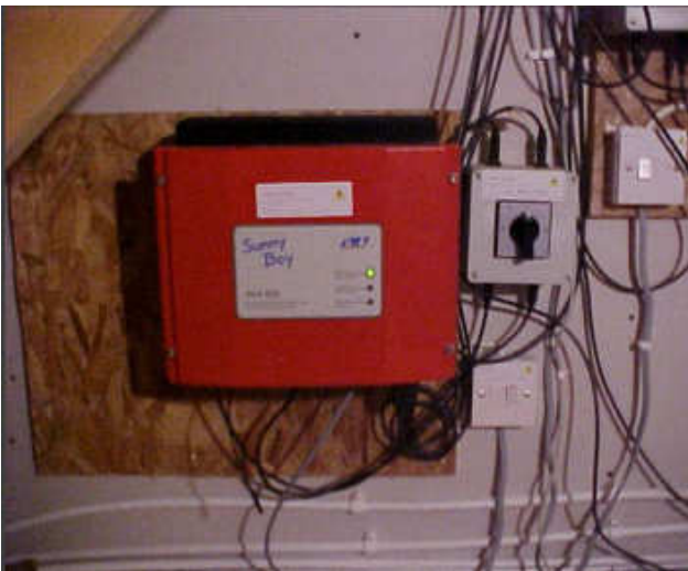
Εικόνα 2: Λανθασμένη καλωδίωση
