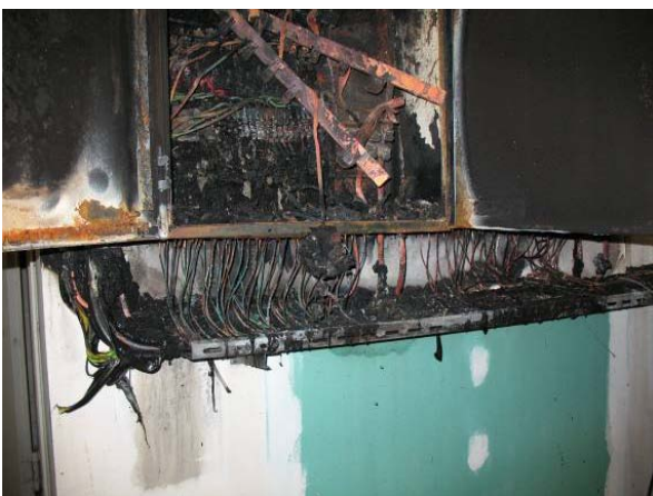
Снимка 3: Късо съединение и претоварен конвертор
