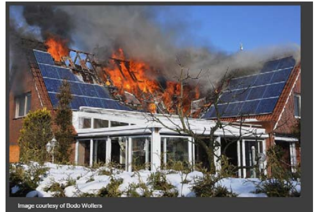
Снимка 1: Собствениците трябва да стоят далеч от PV системата по време на пожар и след него, и да уведомяват бригадата за особени рискове в PV системата.
