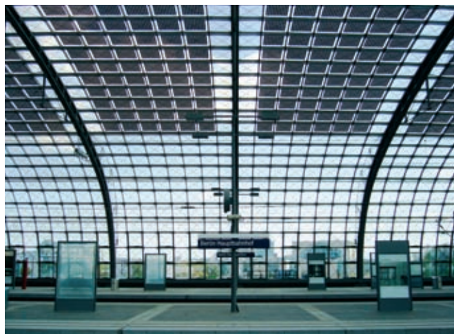
Σύστημα ΦΒΕΚ σε σταθμό τρένου λειτού υμένα (thin film). Πηγή: Scheuten Solar
