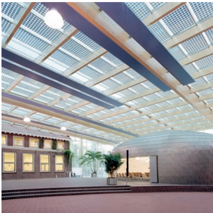
Φ/Β σύστημα πλήρως ενσωματωμένο σε στέγη κτιρίου. Πηγή: Scheuten Solar
