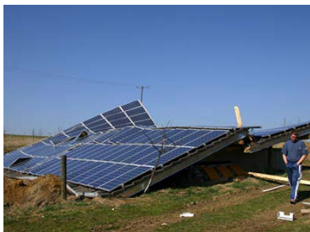
Module PV dărâmate de furtună
