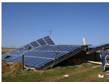
Moduli oštećeni u oluji
