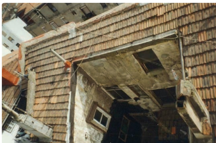
Στέγη κτιρίου υπό εξέταση
